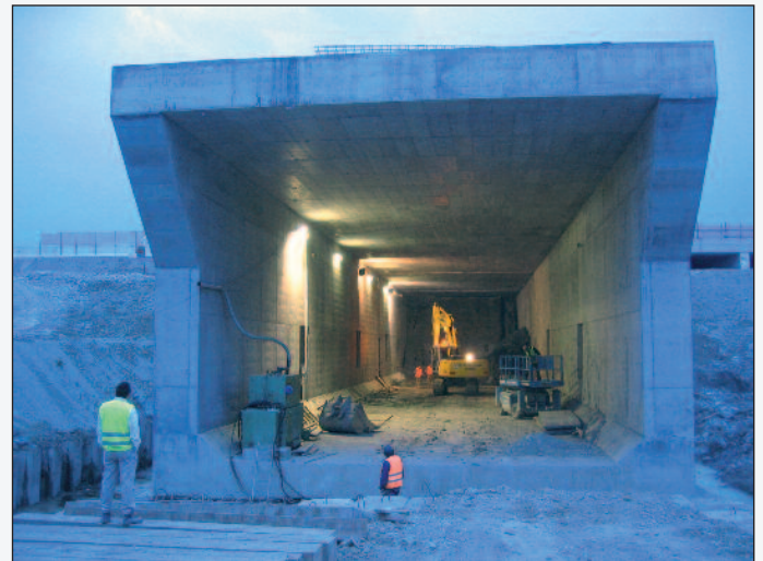
4. Il manufatto visto dall'interno
