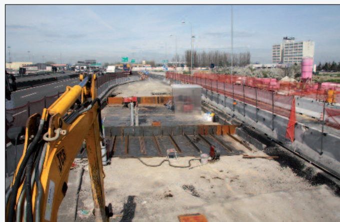
7. Le lamiere laterali e la deviazione autostradale
