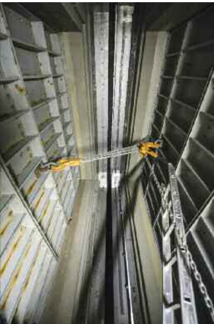
Gate caissons - giunti a tenuta stagna • Gate caissons - watertight joints
