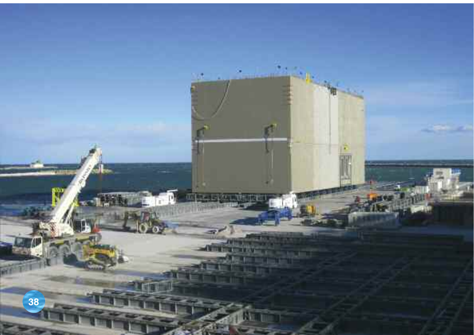
Cassoni di spalla - movimentazione • Shoulder caissons - moving
