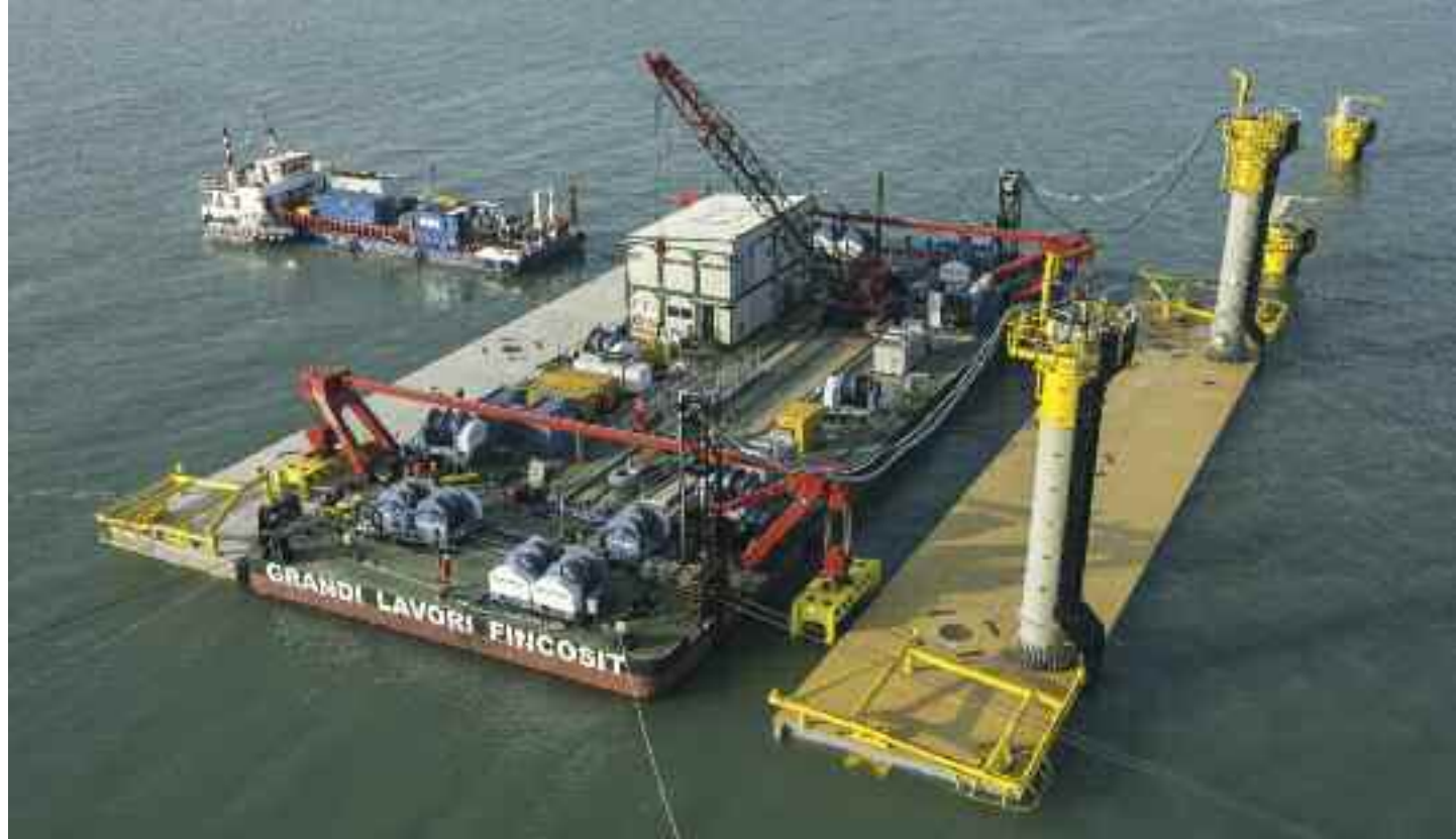
Cassoni di soglia - installazione • Gate caissons - installation
