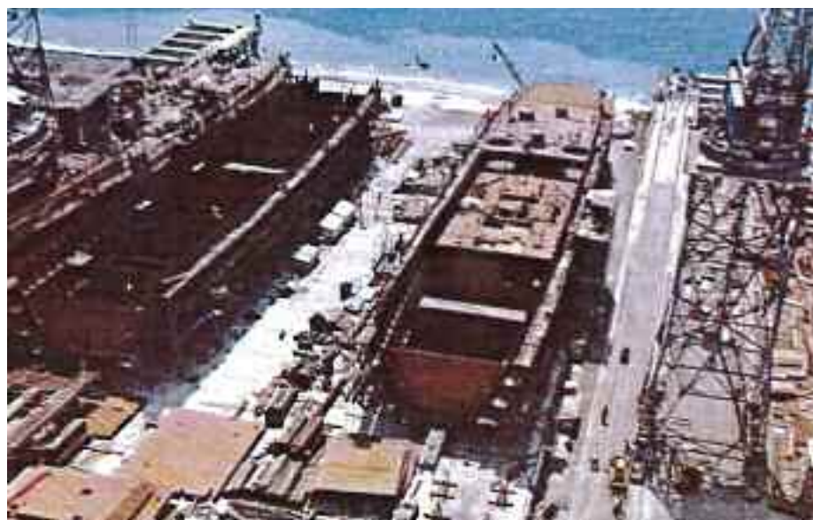
Due navi in costruzione sullo scalo
