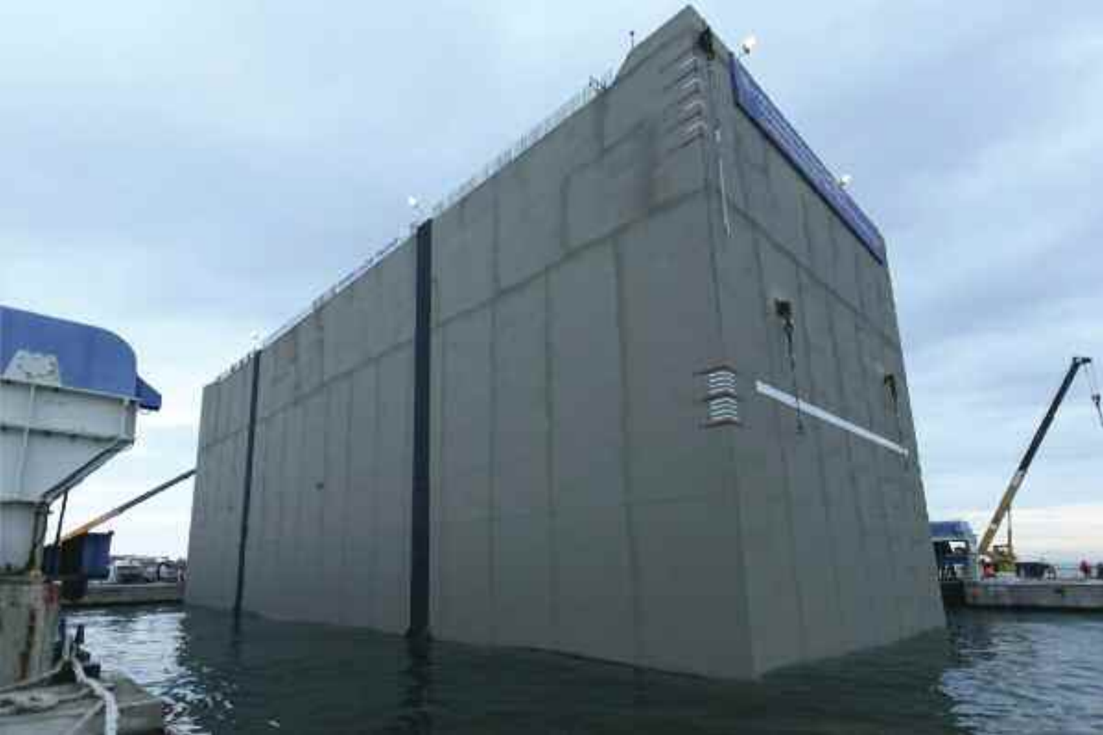
Cassoni di spalla - varo • Shoulder caissons - launching
