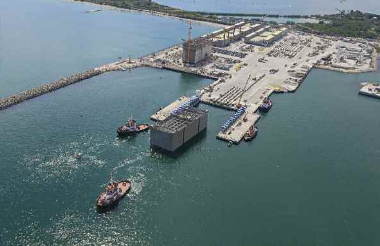
Cassoni di spalla - varo • Shoulder caissons - launching
