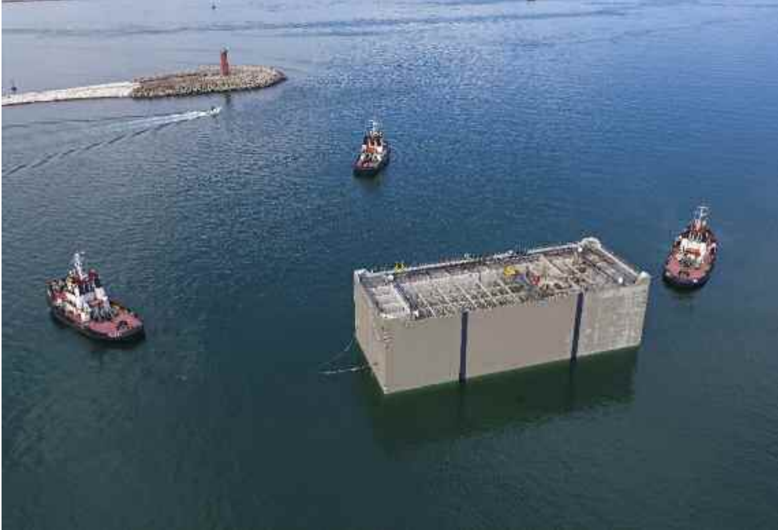
Cassoni di spalla - rimorchio • Shoulder caissons - towing
