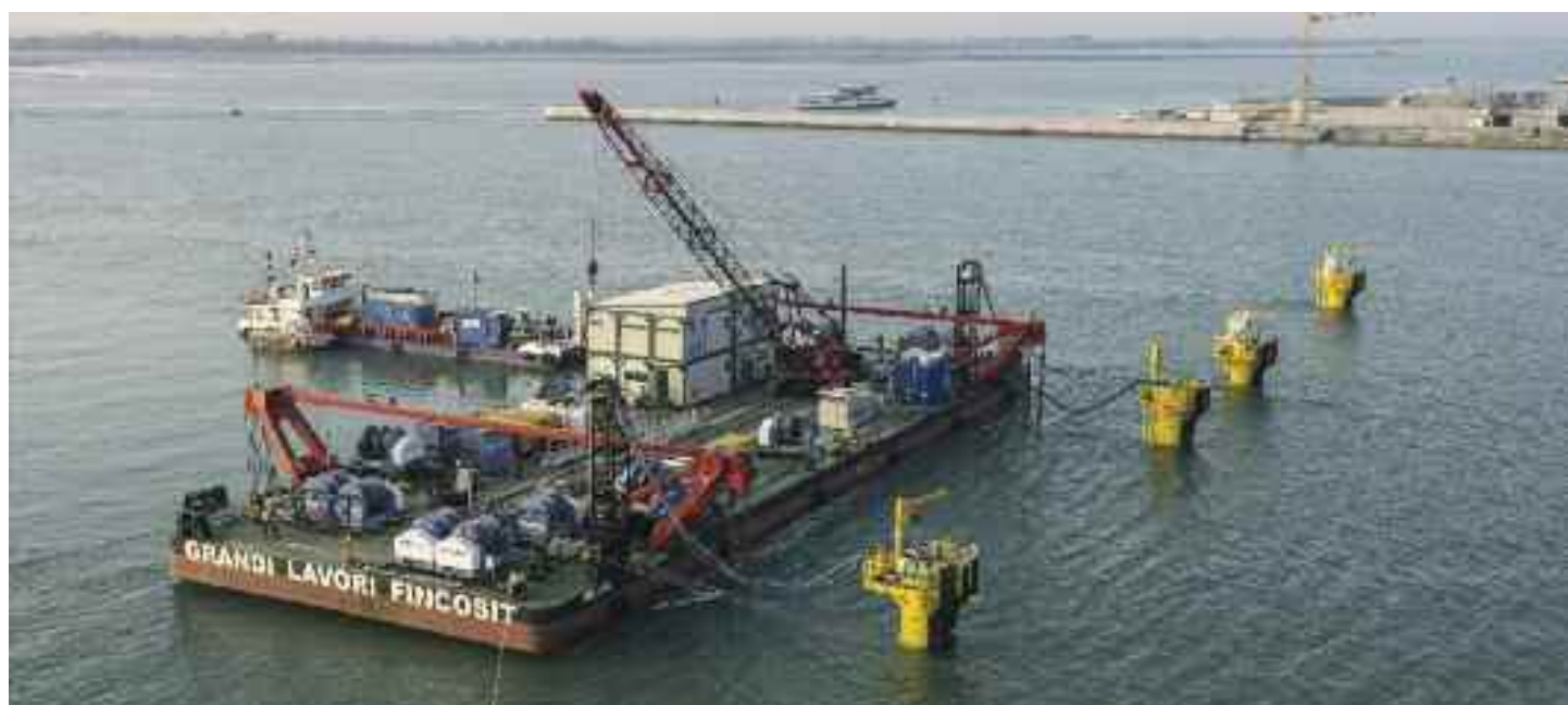
Cassoni di soglia - installazione • Gate caissons - installation
