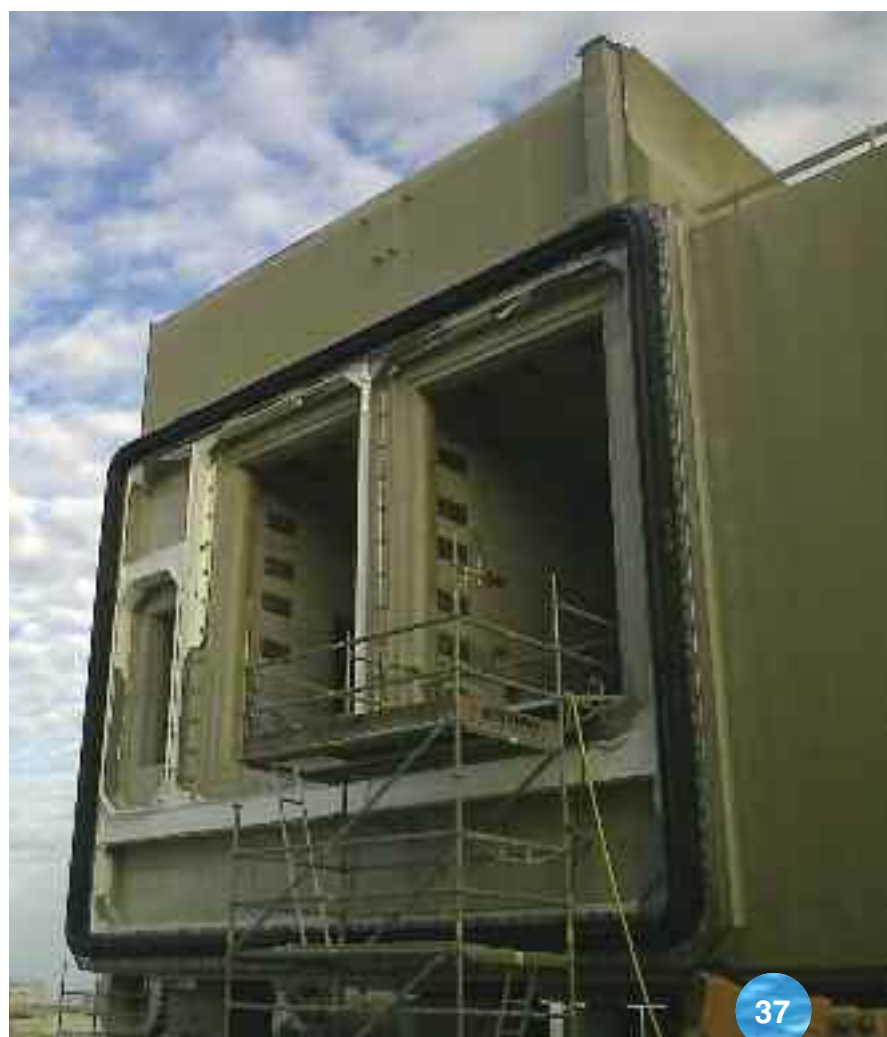
Gate caissons - giunti a tenuta stagna • Gate caissons - watertight joints
