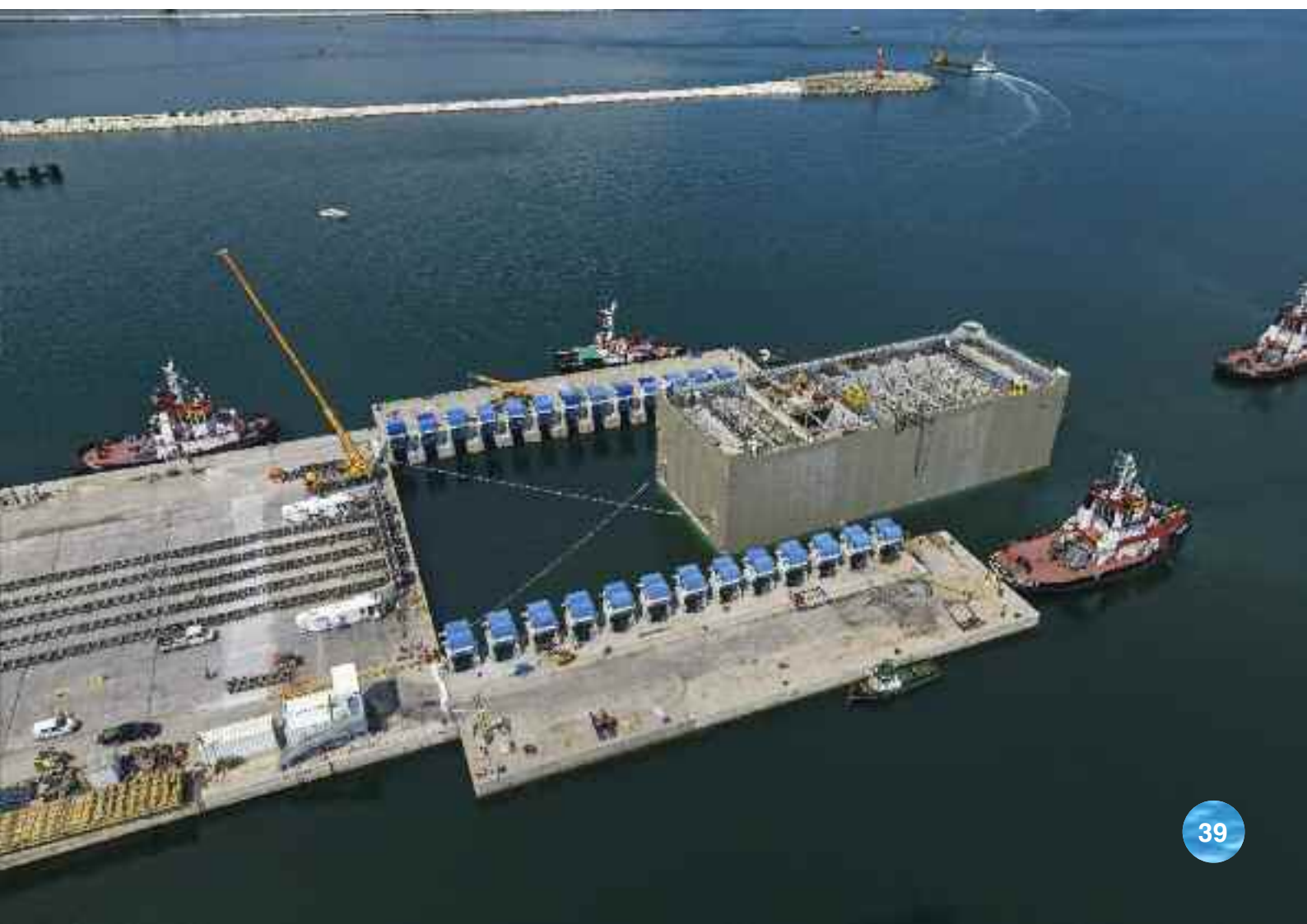
Cassoni di spalla - varo • Shoulder caissons - launching
