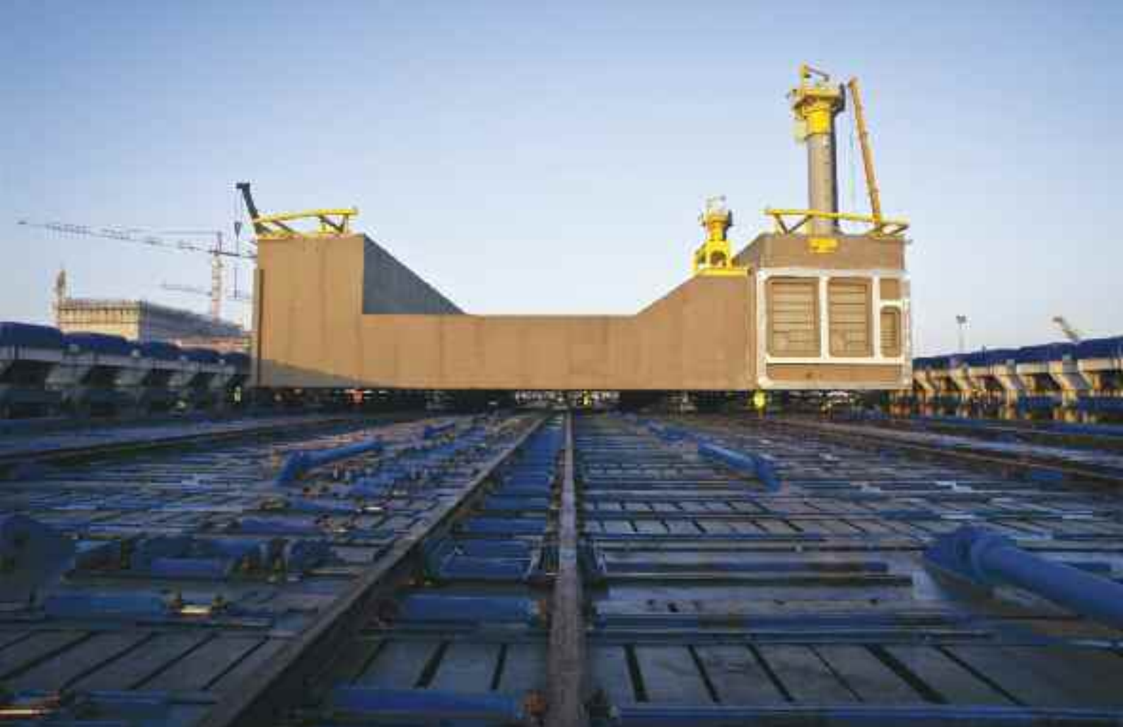
Cassoni di soglia - movimentazione • Gate caissons - moving
