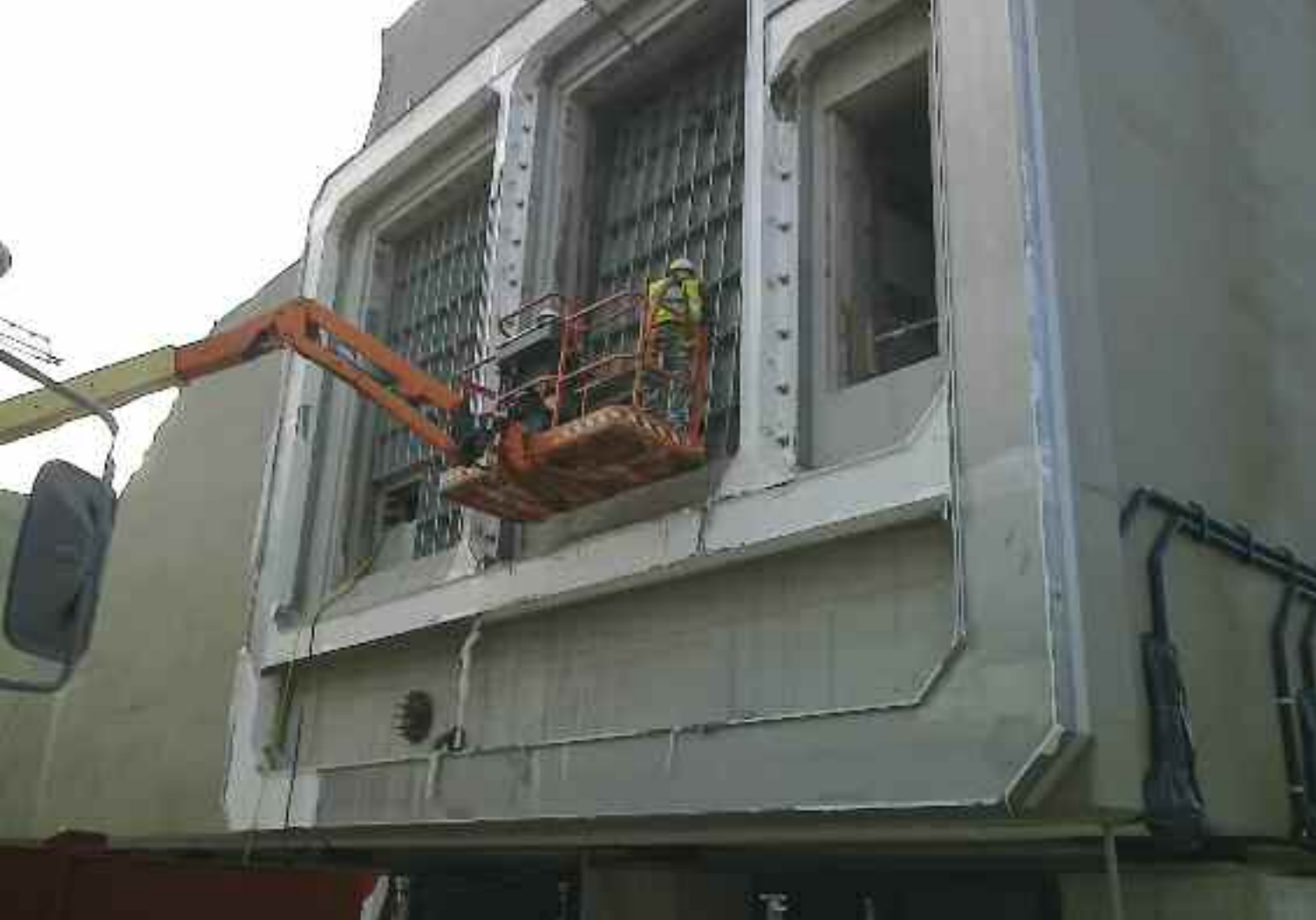
Gate caissons - giunti a tenuta stagna • Gate caissons - watertight joints
