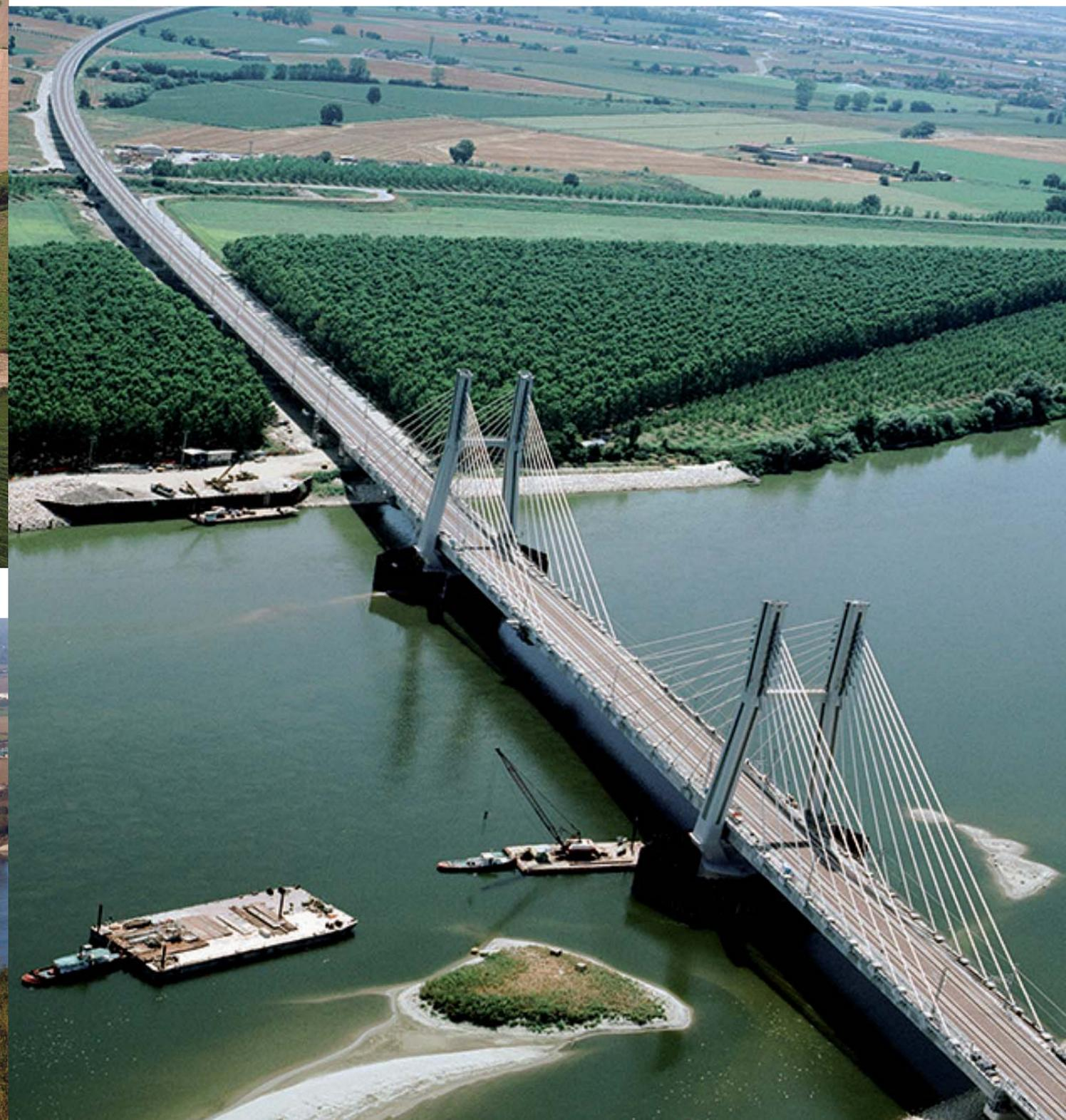
*Linea Ferroviaria ad alta velocità - Capacità Milano - Bologna - Ponte strallato sul fiume Po
