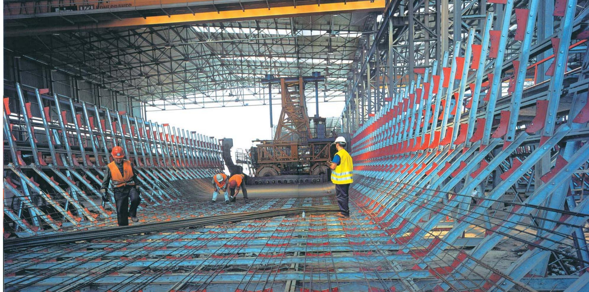
*Armatura viadotto ferroviario • Reinforced concrete steel cages for a rail flyover*
