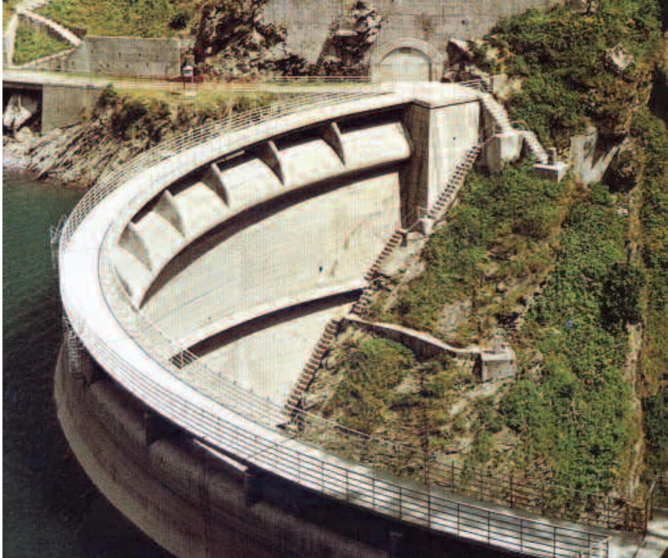
Diga di Boazzo Boazzo Dam
