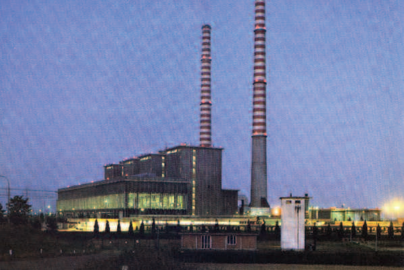
Centrale termoelettrica La Casella (PC) • Thermal power plant at Casella (PC)
