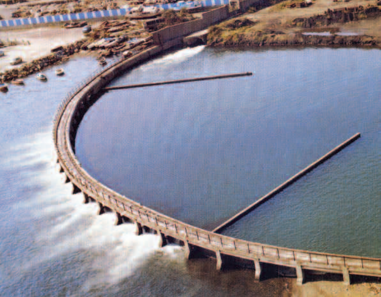
Vasca di decantazione delle acque industriali nelle Acciaierie di Piombino (LI) Waste waters decantation tank in the Piombino Steelworks (Leghorn)
