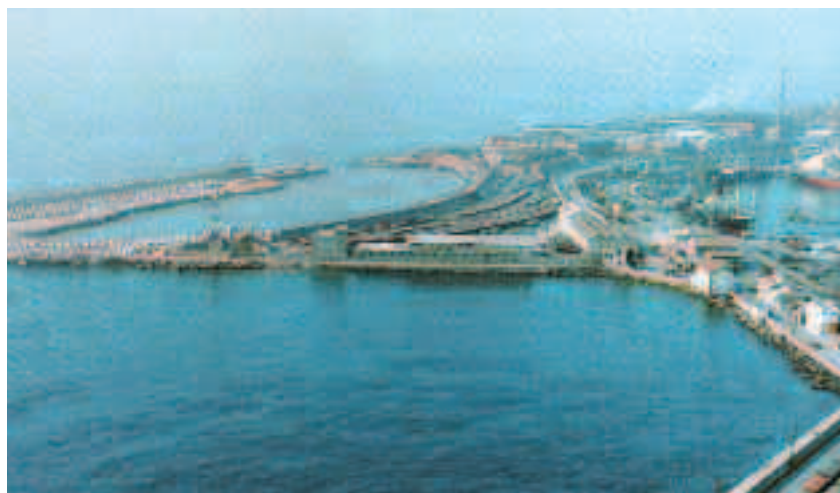
Estensione del Porto di Vado Ligure - Savona Extension of Vado Ligure harbour - Savona
