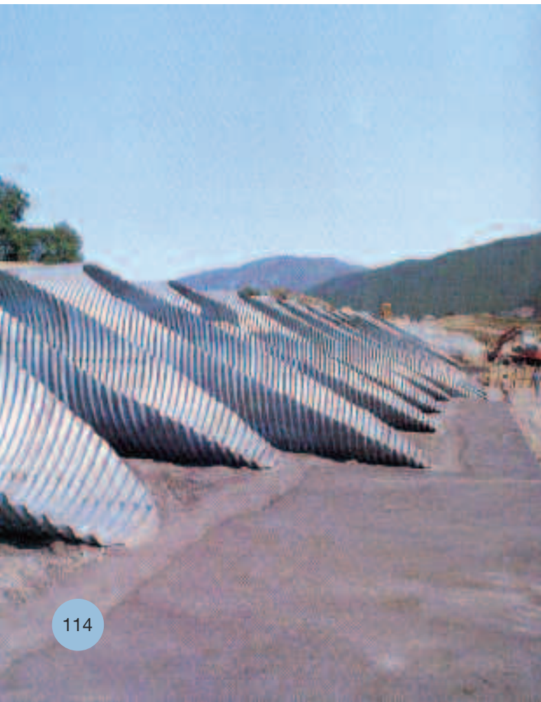
Opere idrauliche a Contursi (SA) • Hydraulic works at Contursi (Salerno)
