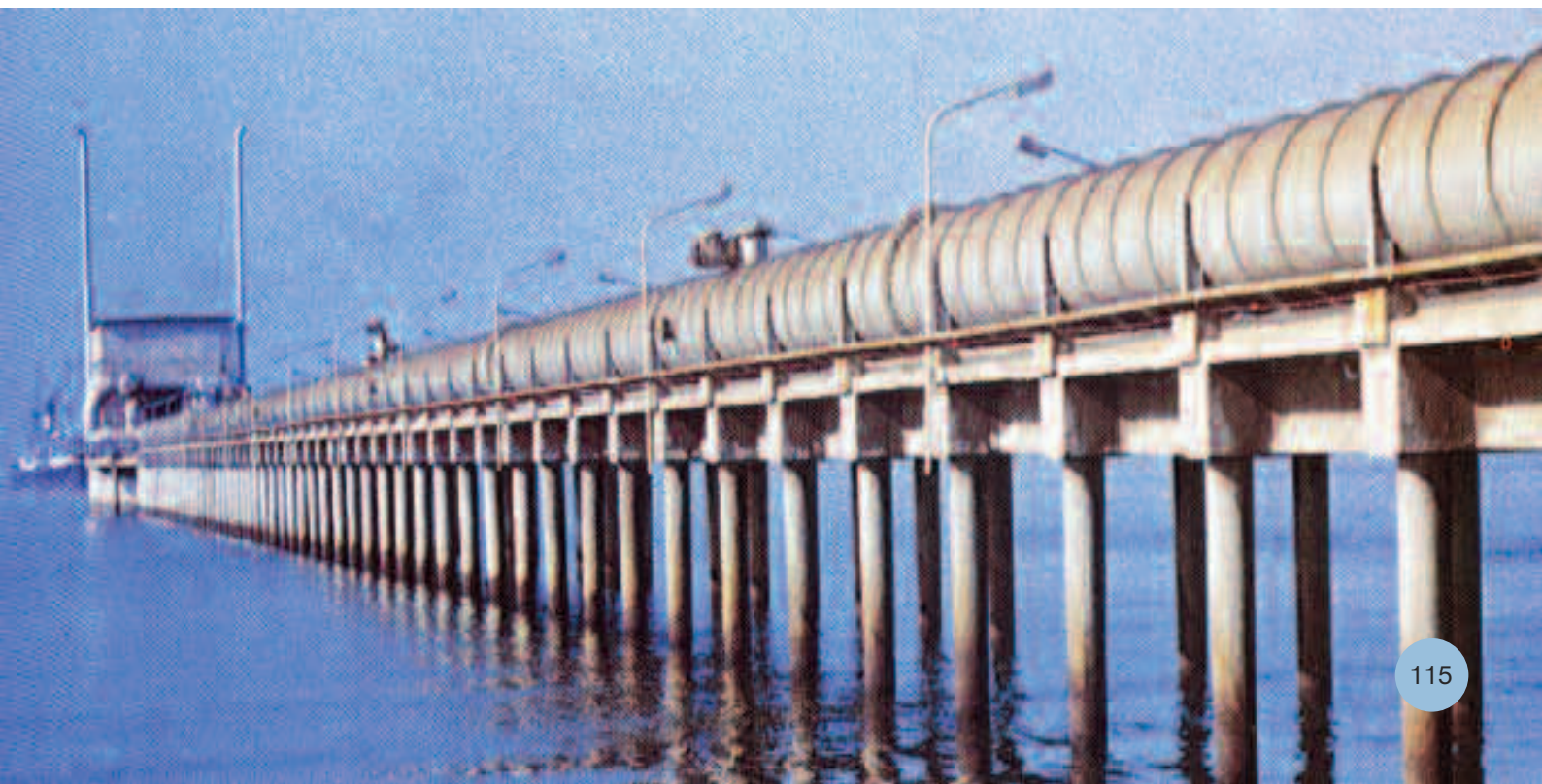
Opera di presa per lo stabilimento Italsider di Bagnoli (NA) Sea-water intake for the Italsider steel plant at Bagnoli (Naples)
