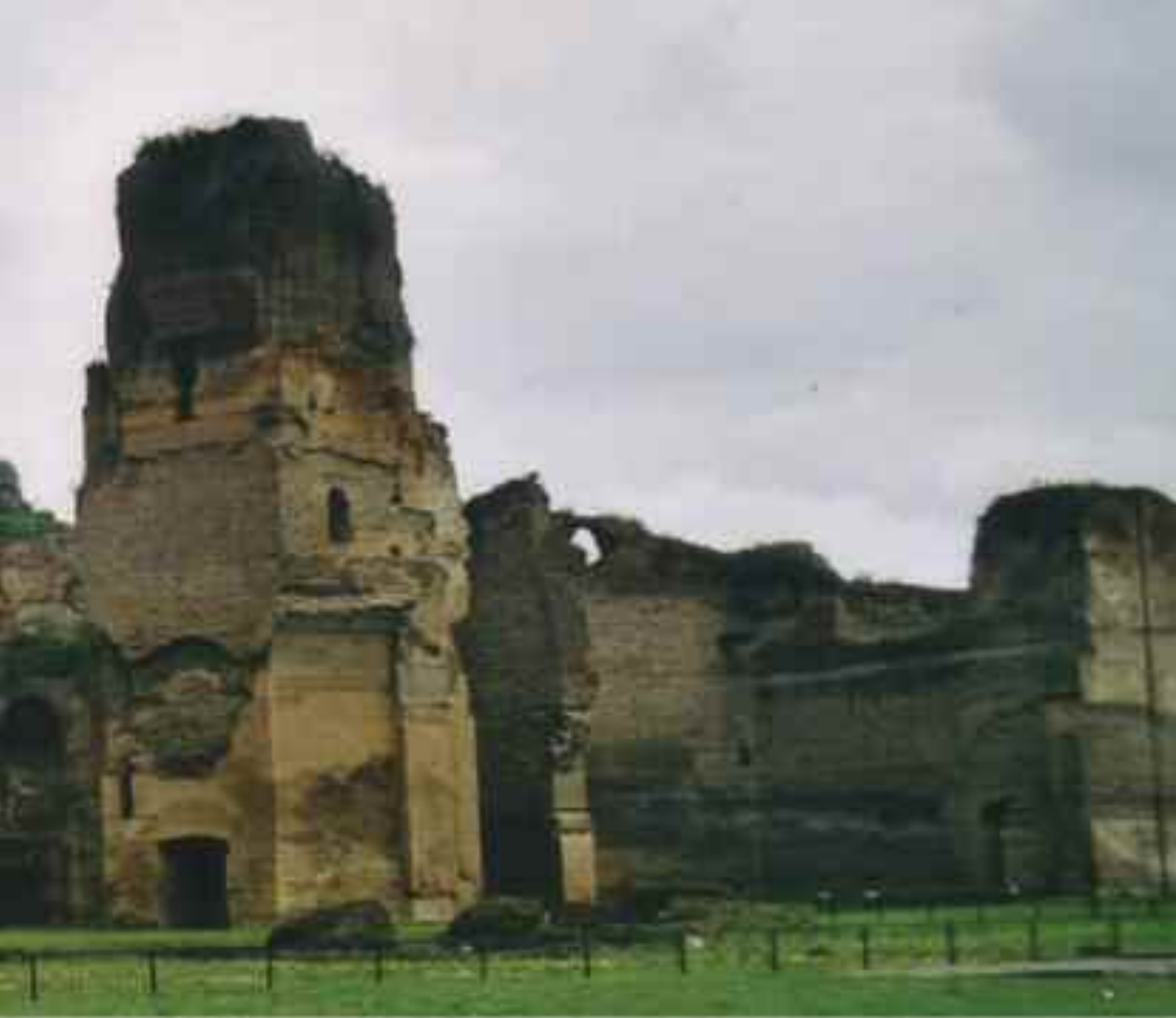
Restauro delle Terme di Caracalla Restoration of the Caracalla Bath
