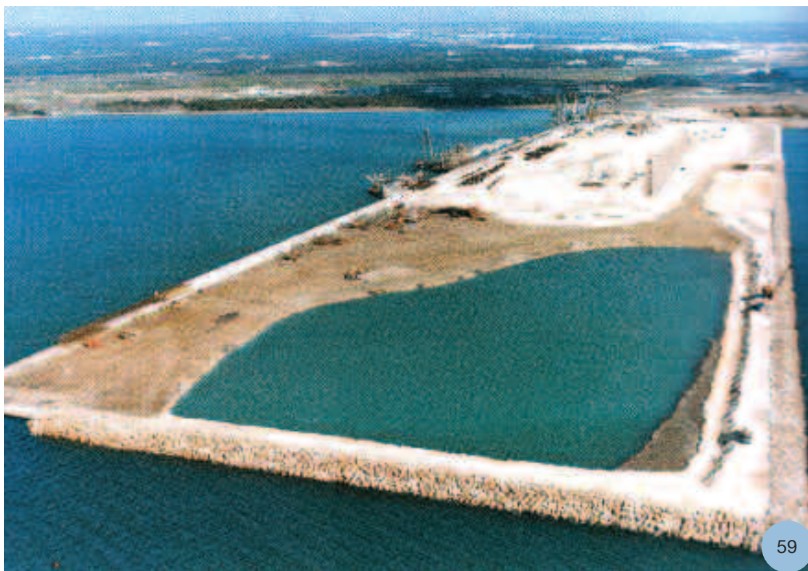
Molo di Porto Ovest a Taranto • West Port at Taranto - the wharf
